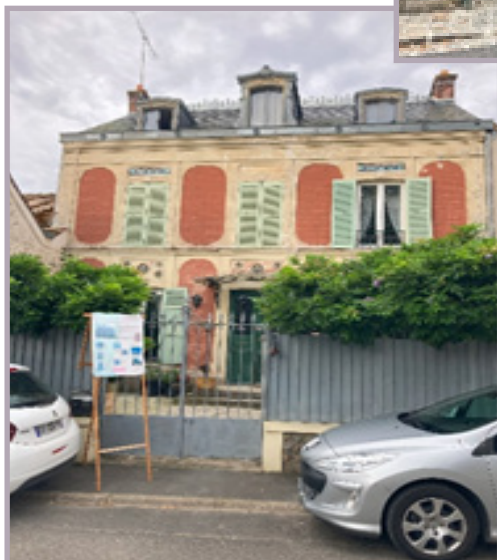
Maison de bourg au 10 rue du four à chaux
